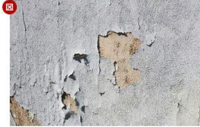
شكل رقم ٤: جدران خارجية متشققة
